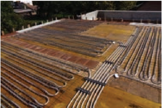
Dokončený systém SLAB16 připravený k předání pracovního prostoru
