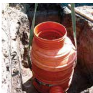
Šachta ve výkopu Obr. 15
