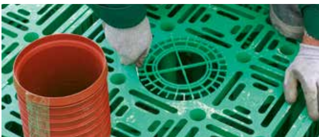
Vývod potrubí dn 200 mm
