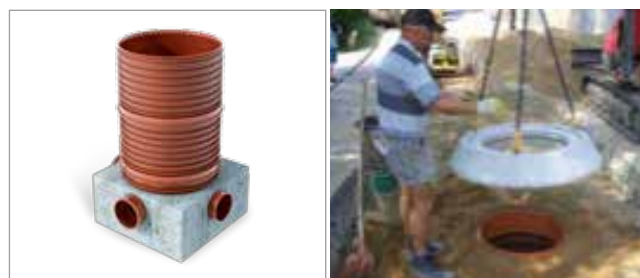
Obetonování Obr. 19 Osazení prstence Obr. 20
