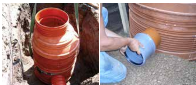
Šachta ve výkopu Obr. 15 Flexibilní hrdlo Obr. 16
