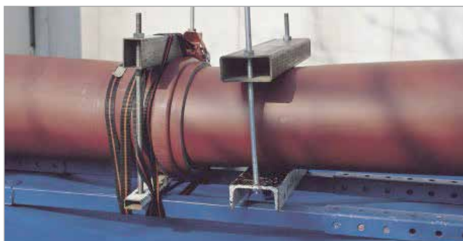
Zkouška těsnosti spoje (PP MASTER)
