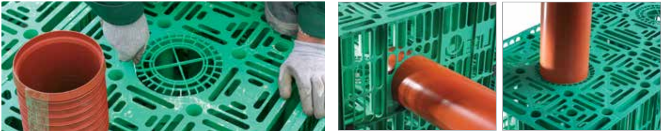
Vývod potrubí d_p 200 mm
