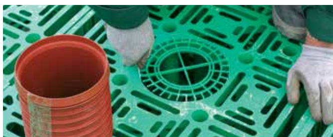
Vývod potrubí d_n 200 mm
