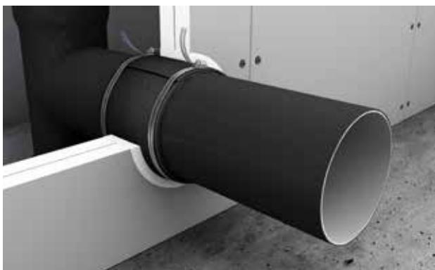
Při prostupu instalační šachtou se přikládá vhodný počet vrstev Hensotherm 7KS 100 mm protipožárního rukávce okolo trubky tichého odpadního systému, pokud prochází jednostranně opláštěnými stěnami šachty.
