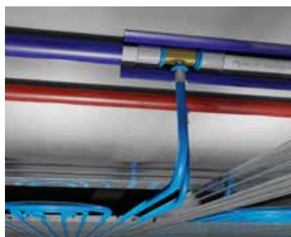
26 – Připojení trubky 10x13 mm na rozvodné vedení
