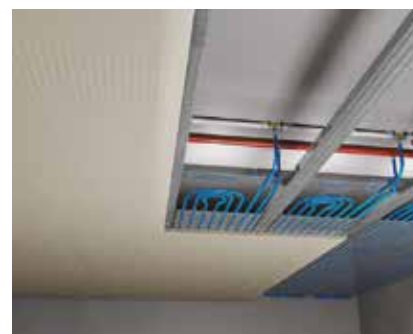
27 – Pokrytí hotových topných a chladičích panelů
