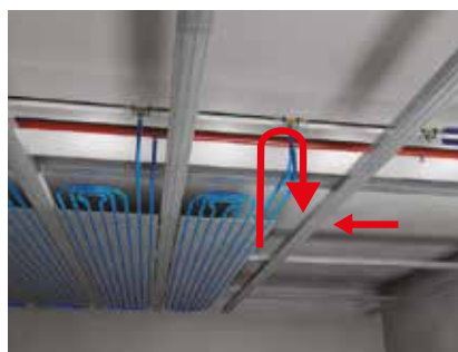
24 – Zasunutí profilu CD na místo (vzdálenost od středu ke středu - 400 mm)
