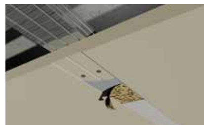
Sádkové omítnutí zkosených spojů
