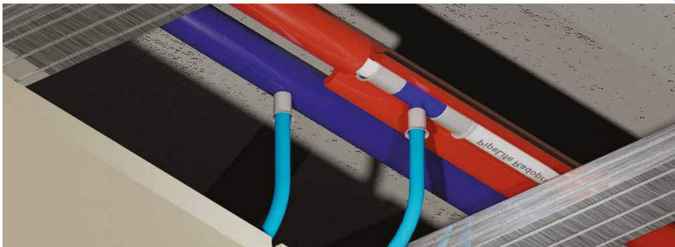
zapojený a izolovaný T-kus
