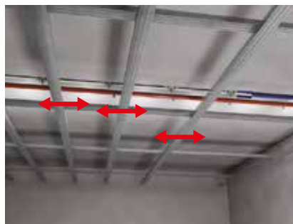
22 – Připravená nosná konstrukce CD profil vzdálenost od středu ke středu > 400 mm
