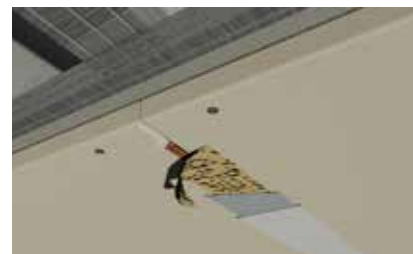
Sádkové omítnutí tupých spojů
