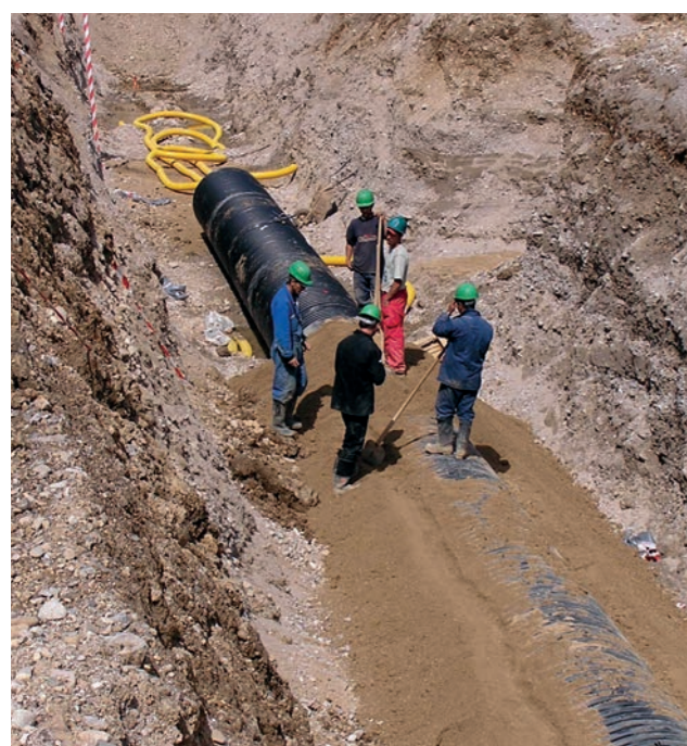
Zhutnění hlavního zásypu
