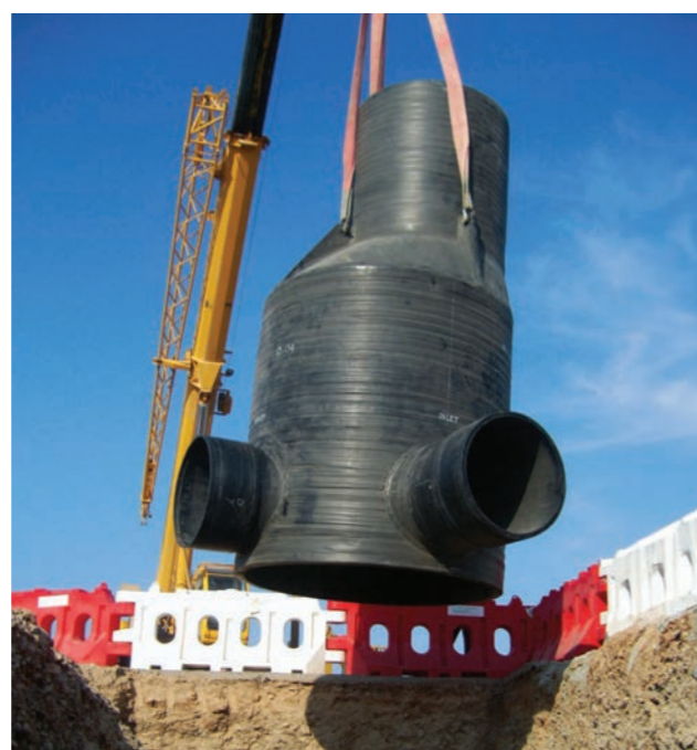
Usazení šachty na místo instalace
