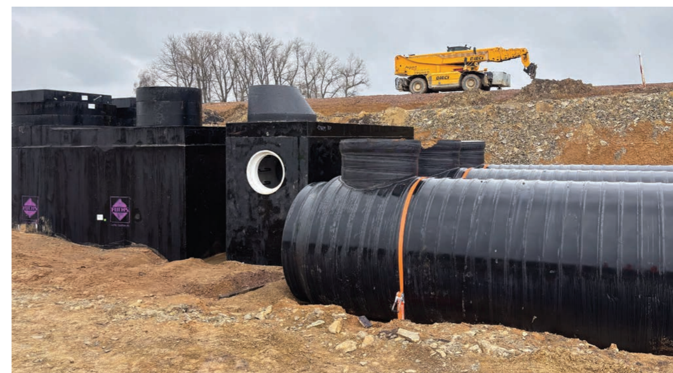
Instalace šachet a retenčních prvků na stavbě
