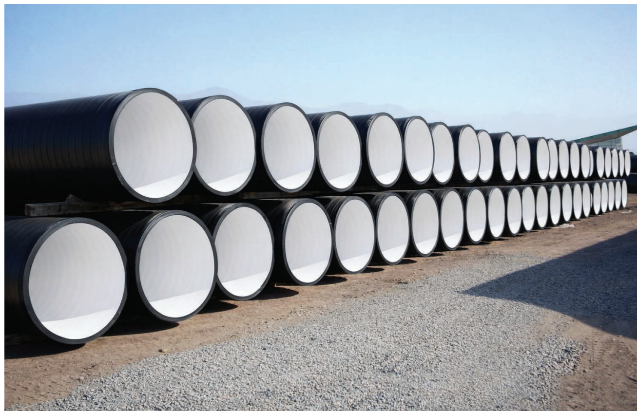
Skladování v místě instalace
