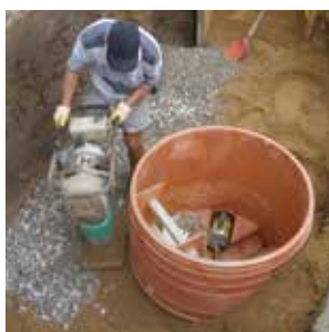
Hutnění zeminy Obr. 17
