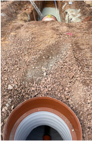
Obr. 7. Zásyp trubních dílů
