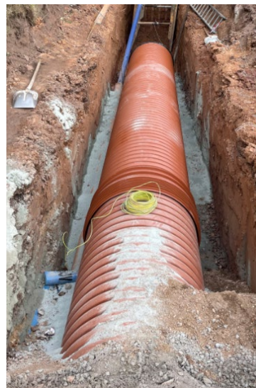
Obr. 6. Obsyp trubních dílů
