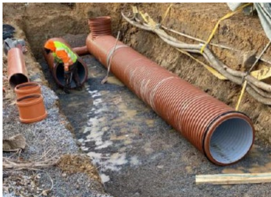
Obr. 5. Pokládka trubních dílů
